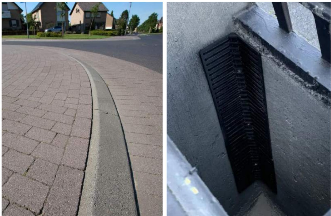
Figuur 6.13 Schuine trottoirband (links) Bron: MBI.nl en amfibietrap (rechts). Bron: Vivara.nl
